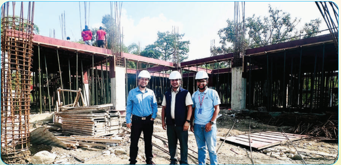
गण्डकी विश्वविद्यालयको निर्माणाधीन मुख्य प्रशासकीय भवन अनुगमनका क्रममा रजिष्ट्रार योजना तथा विकास शाखा प्रमुख ई. सुदिप कोइराला
